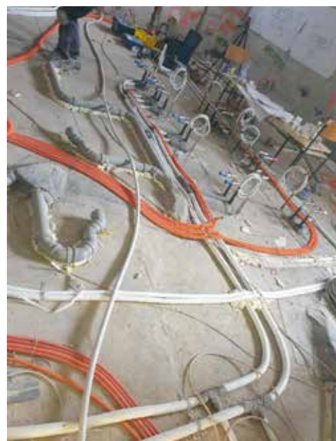
Polaganje instalacij za nov termoblok
