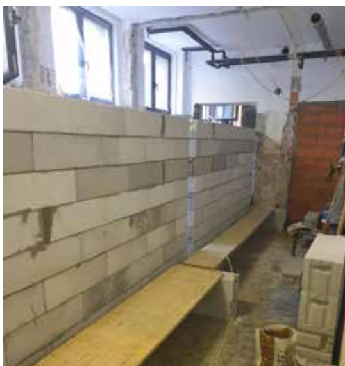
Izvedba pregradnih sten
